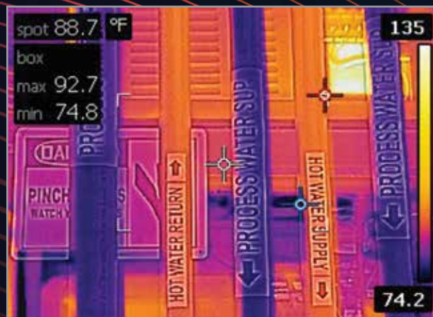
FLIR获得专利的MSX®技术在不影响测量数据显示的条件下，亦能读取文本和可见光细节信息
